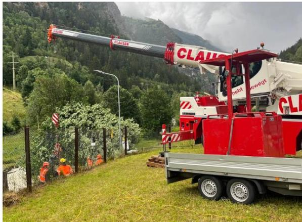
**Provisorische Erstreparatur/ Befestigung Stahlrohr inkl. MS-/LWL-Kabel**
